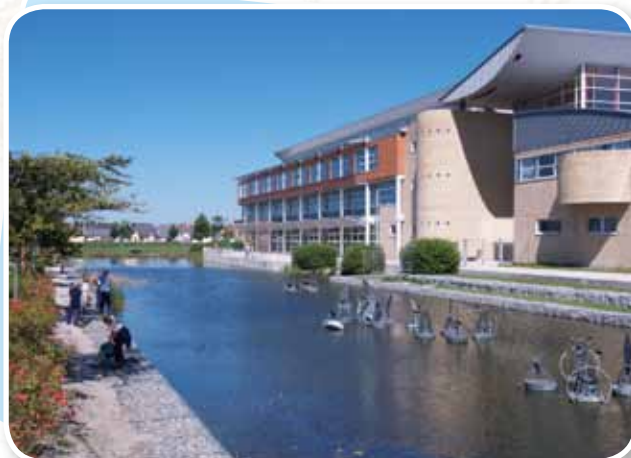
Le Lycée HQE de Calais Léonard de Vinci récupère les eaux de pluie pour les toilettes et l'arrosage.
