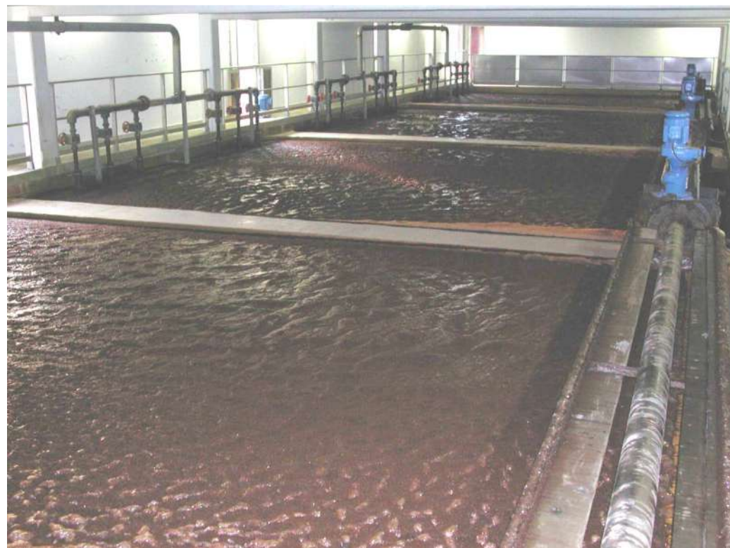
Procédé pour traiter l'eau (flottation) afin de la rendre potable - Usine de Houlle Moulle
