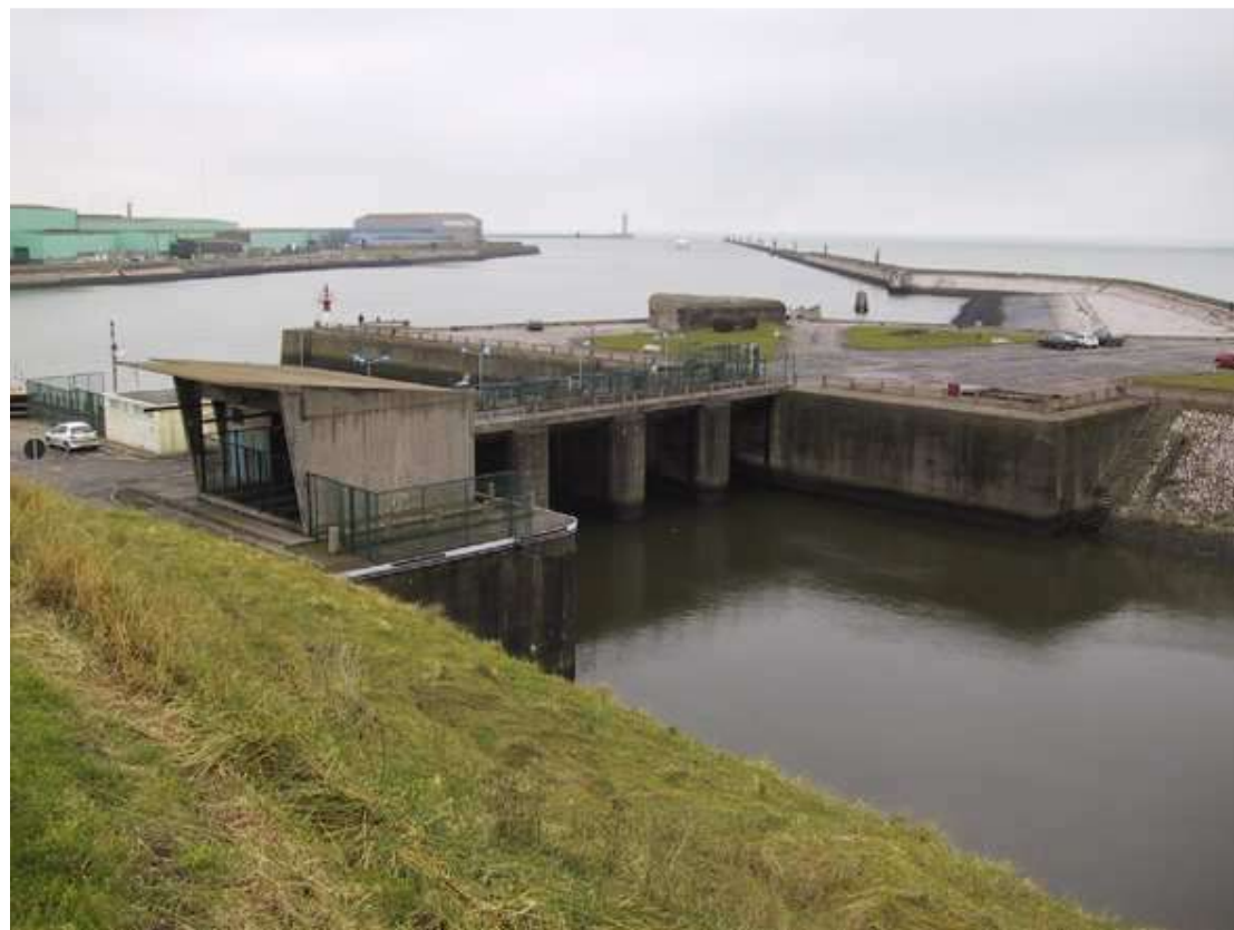
Portes à la mer à DUNKERQUE
