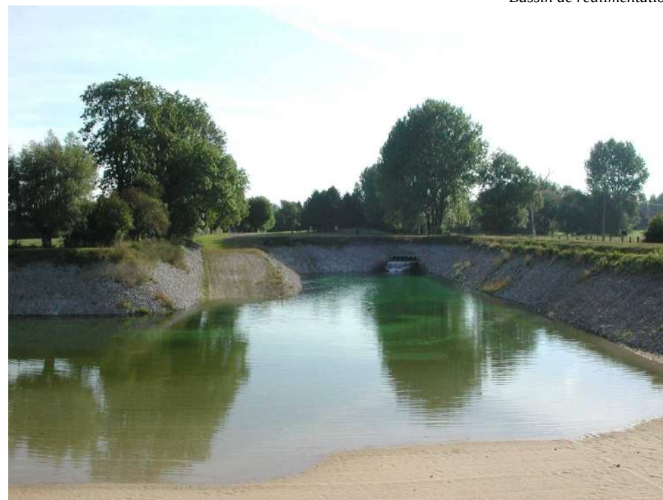
Bassin de réalimentation
