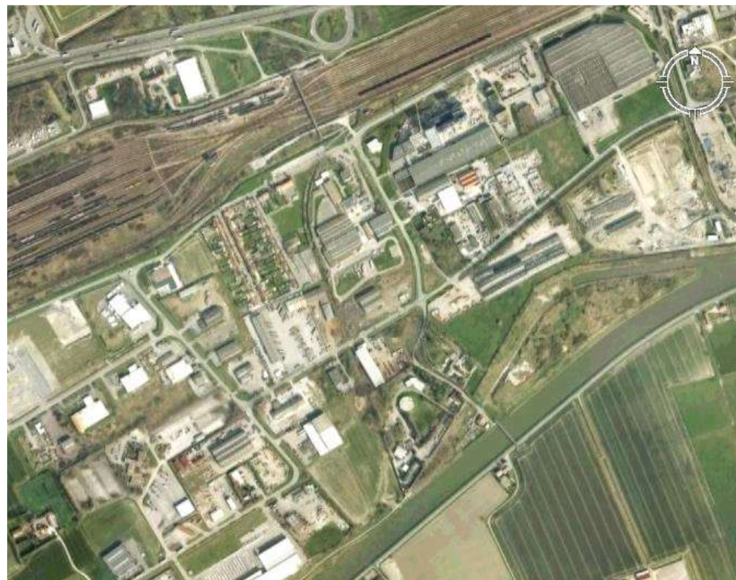
Zone Industrielle des Deux-Synthe à Dunkerque
