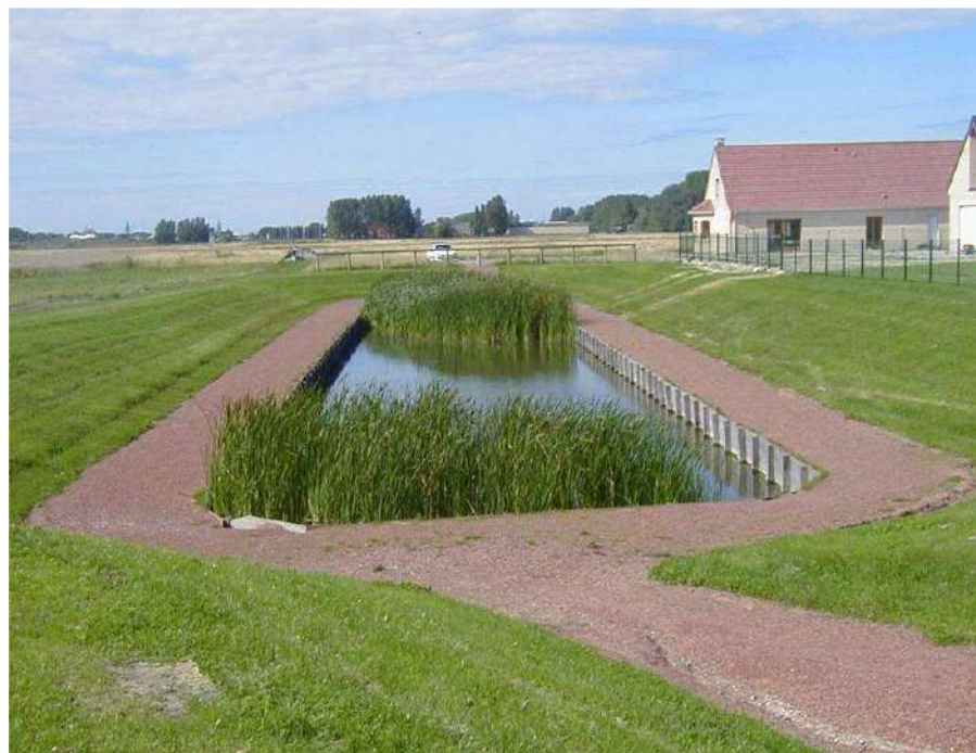
Bassin de stockage des eaux pluviales dans la 4 ème section des wateringues du Nord
